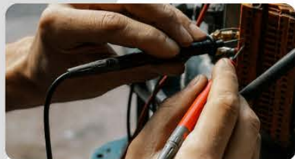
Dto. de Mantenimiento Propio
